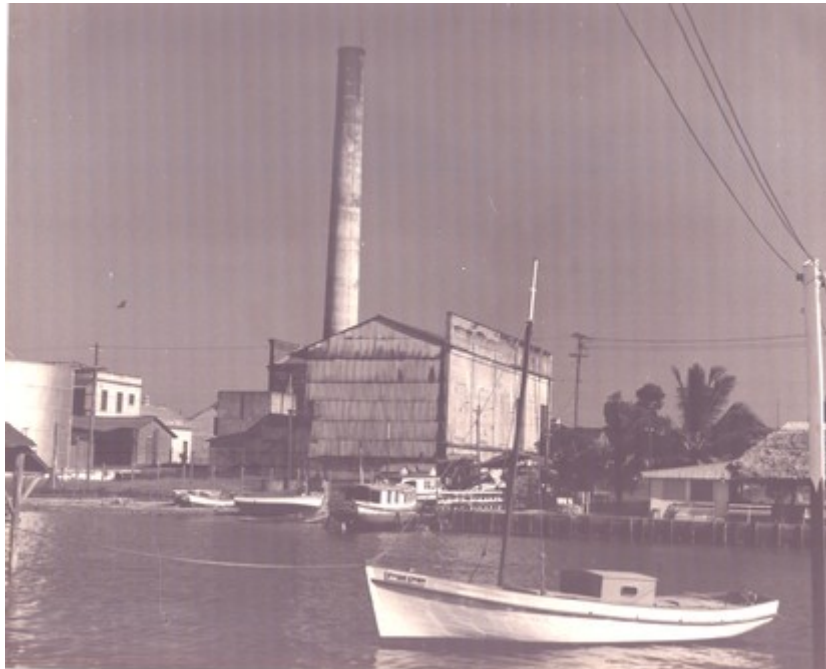
Planta eléctrica construida por la Compañía de Electricidad de Manzanillo.
